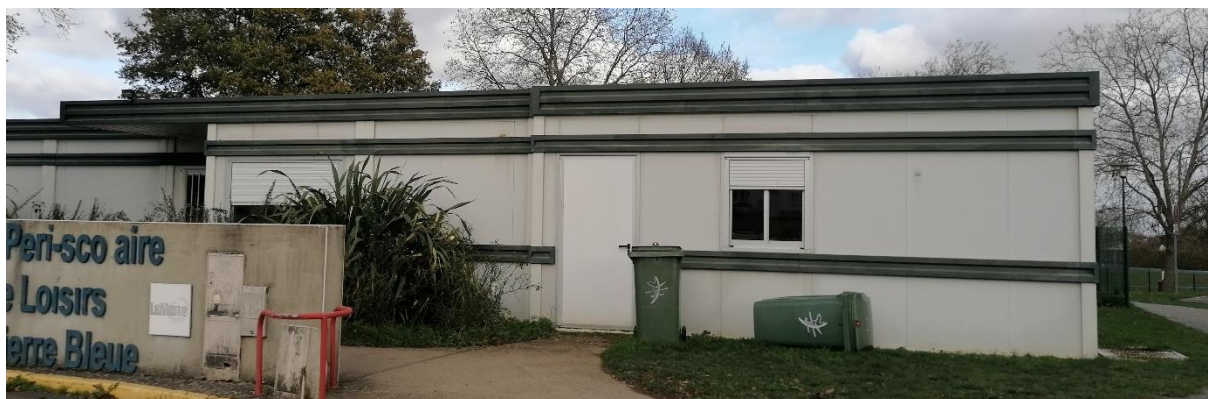
Accueil périscolaire (3) (source la boîte de l'espace)
