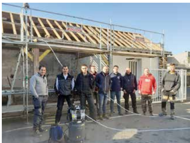
Le chantier de la toiture du préau en décembre 2021, avec une partie de l'équipe de bénévoles qui a contribué au chantier.
