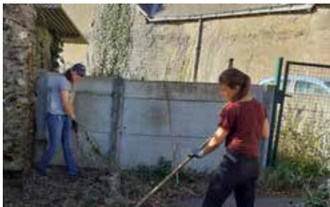
Chantier citoyen à Treffieux
