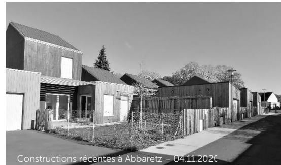
Constructions récentes à Abbaretz – 04.11.2020
