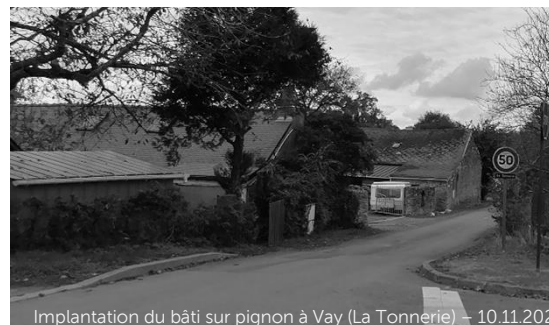
Implantation du bâti sur pignon à Vay (La Tonnerrie) – 10.11.2020
