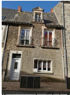
Mise en œuvre de menuiseries PVC avec des montants épais, porte également en PVC, le tout blanc pur.
