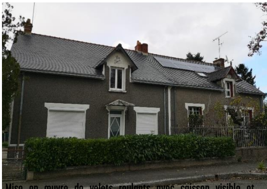
Mise en œuvre de volets roulants avec caisson visible et menuiseries PVC, le tout blanc pur.
