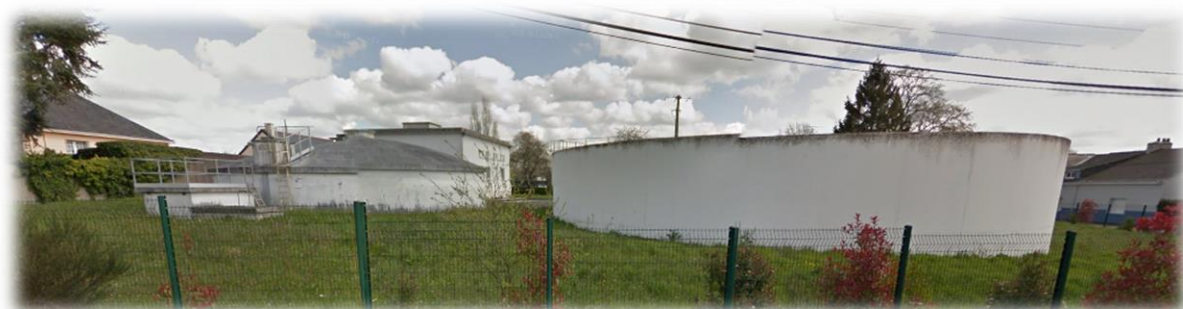
Photo des réservoirs situés sur Abbaretz
