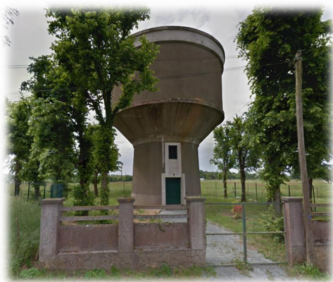
Photo du château d'eau « le Petit Tertre » à Nozay
