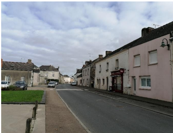
Vue sur la rue principale
