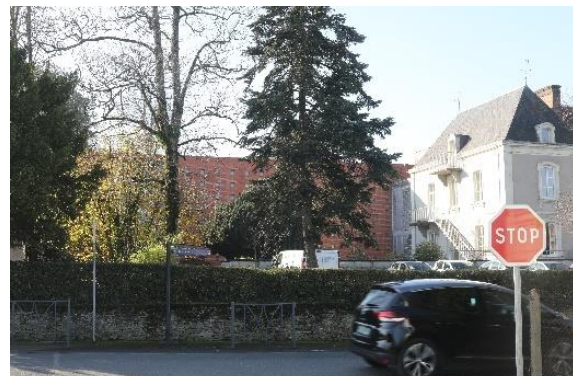
Centre hospitalier « La Chesnaie » à Nozay – 26.11.2020
