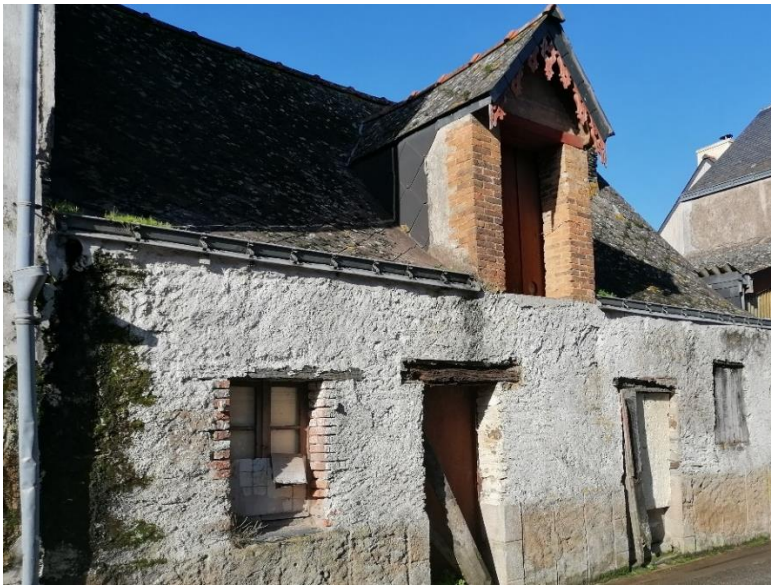
Habitation vacante à réhabiliter à Saffré (03.11.20)
