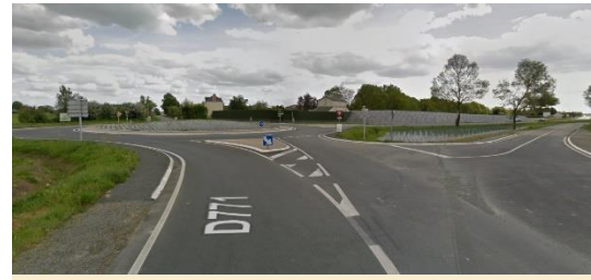
D771 : la déviation du bourg de Treffieux a permis de dévier les poids lourds du bourg (plus de 500/jour)
