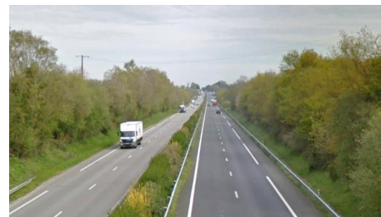
RN137, depuis le pont de Nozay
