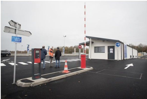
Entrée avec contrôle d'accès
