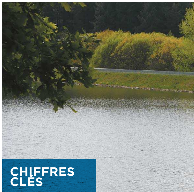
Retenue, prise d'eau et digue du barrage de Haute Vilaine
