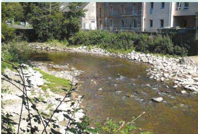
Seiche : effacement de l'ouvrage de Carcé
