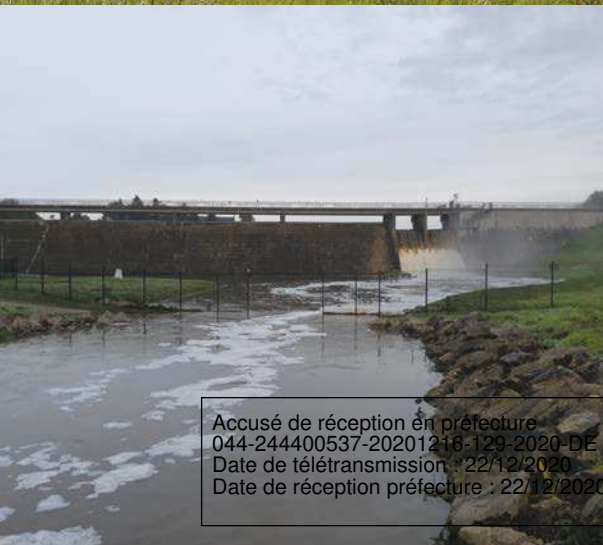
Clapets et déversoir de sécurité du barrage de la Cantache
