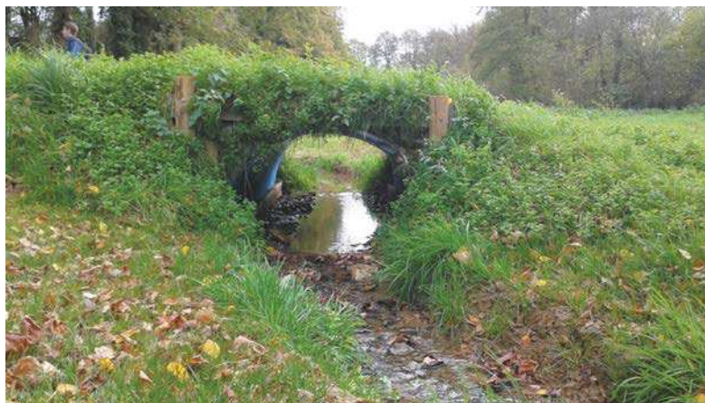
Seiche (Ruisseau du Belardon) : ouvrage de franchissement
