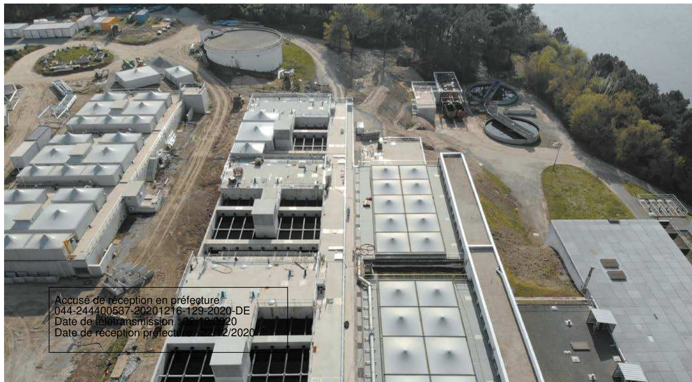
Usine de Férel : 2 ème étage de traitement en voie de finalisation
