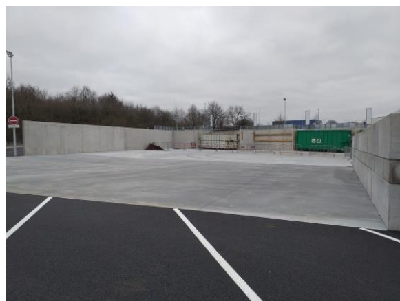
Plateforme déchets verts
