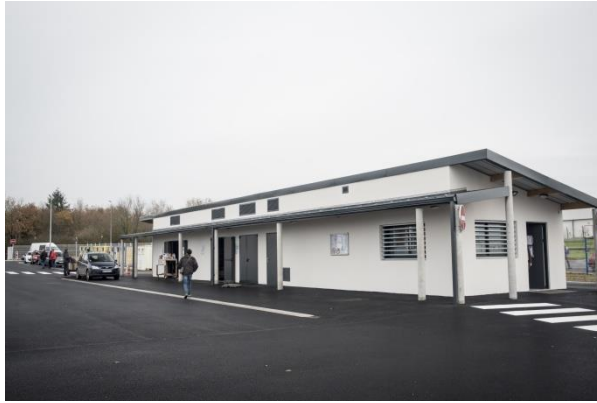
Bâtiment avec local pour les agents et espaces de stockage (déchets dangereux, réemploi et DEEE)
