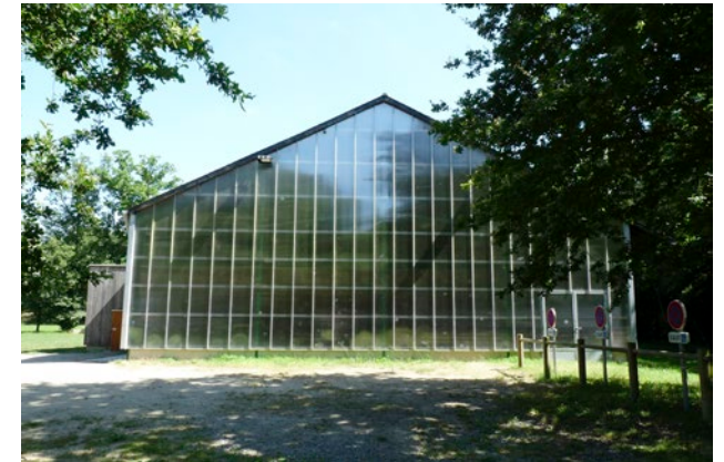
Halle du Gruellau, façade nord-ouest.
