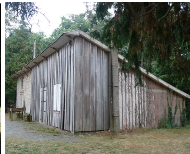
Façade patchwork constituée de matériaux hétéroclites.
