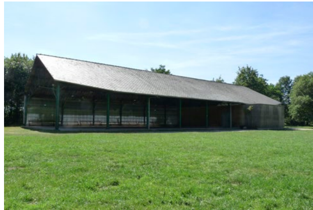
Halle du Gruellau vue est.
