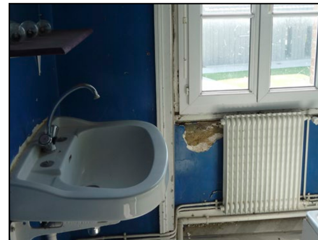
Salle de bain côté rue.
