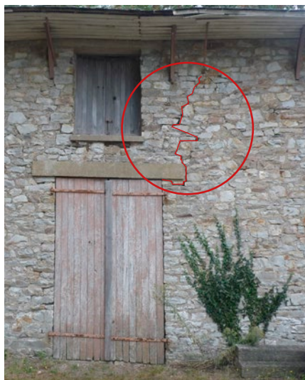
Fissure qui s'est créée puis propagée du linteau de la porte au faîtage du toit.
