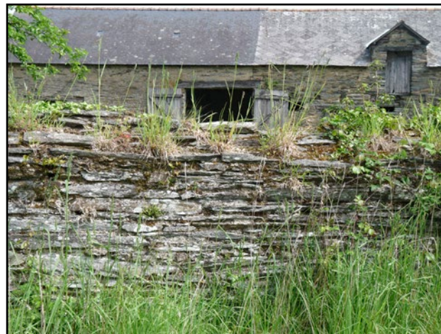
Très bel ensemble mur de clôture et bâti ancien sur le parcelle voisine.
