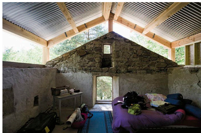
Ancienne porcherie. Création d'un nouveau volume intérieur préfabriqué et pose d'une nouvelle couverture-NAUMANN ARCHITEKTUR- COO ARCHITECTES-Allemagne.
