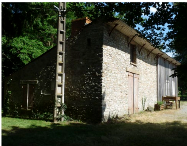
Le maque d'intégration des réseaux électriques.
