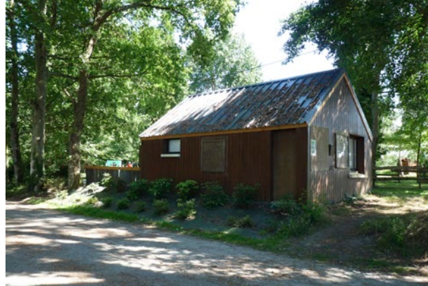
Bar actuel et rapport au cheminement routier, vue nord-ouest.
