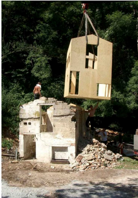
Ancienne porcherie. Création d'un nouveau volume intérieur préfabriqué et pose d'une nouvelle couverture-NAUMANN ARCHITEKTUR- COO ARCHITECTES-Allemagne.
