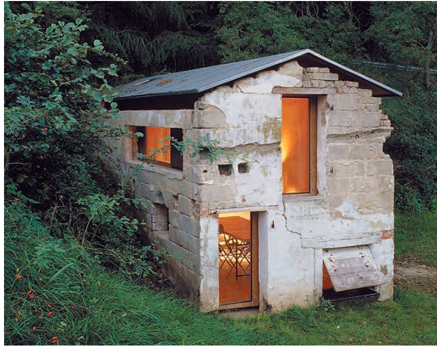
Ancienne porcherie. Création d'un nouveau volume intérieur préfabriqué et pose d'une nouvelle couverture-NAUMANN ARCHITEKTUR- COO ARCHITECTES-Allemagne.
