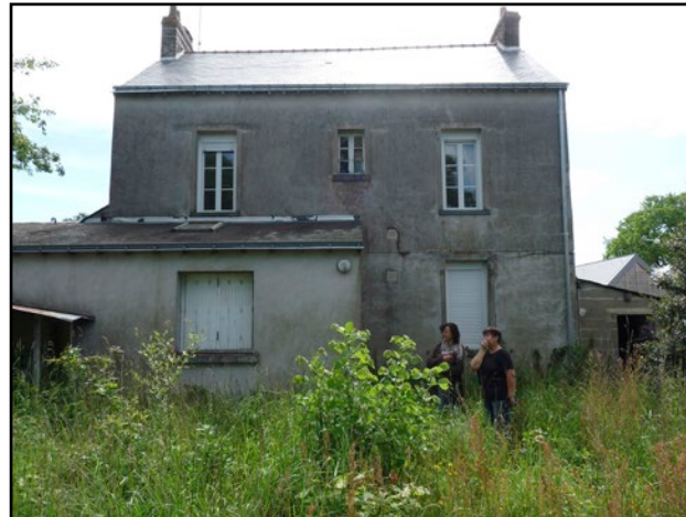
Les volumes réalisés en extension ne présentent pas d'intérêt.
