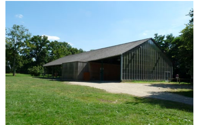
Halle du Gruellau vue sud.
