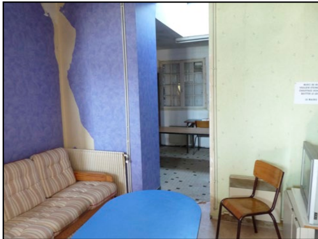
Pièce au RDC, donnant accès à l'extension.
