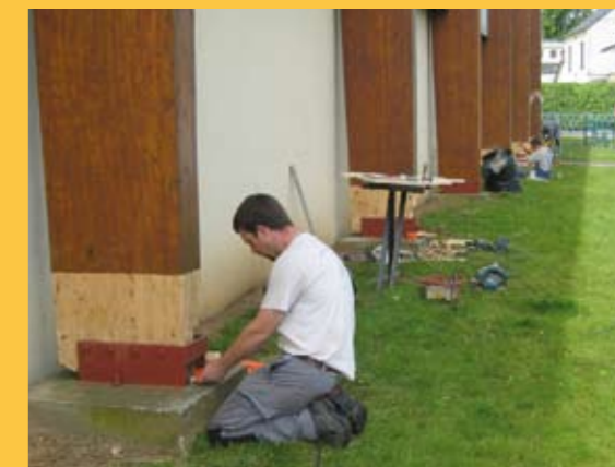
Reprise des piliers du Gymnase du Pré Saint-Pierre.
